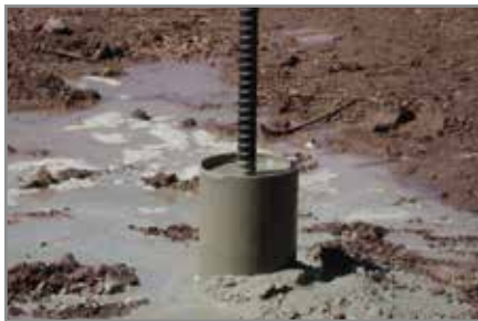
Revestimiento roscado de micropilotes instalado con barras reforzadas 75 ksi completamente roscadas
